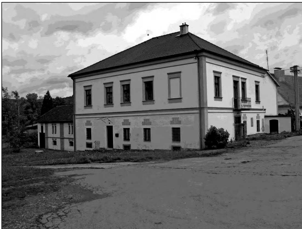
Obrázek 4 Bývalý mlýn čp. 70 ve Štáhlavech (dnešní stav)
